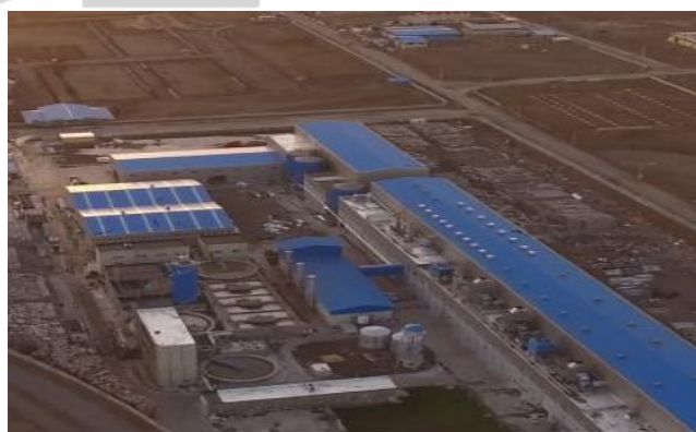
پروژه: راشا کاسپین ایرانیان سال اجرا: ۱۳۹۸ نوع پروژه: ساندویچ پانل
