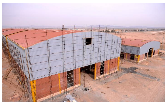
پروژه: چسب استحکام سال اجرا: ۱۳۹۷ نوع پروژه: ساندویچ پانل و پلی کربنات
