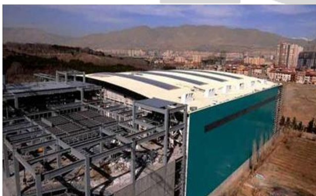
پروژه: پارک آبی چیتگر (O park) سال اجرا: ۱۳۹۶ نوع پروژه: ساندویچ پانل و پلی کربنات
